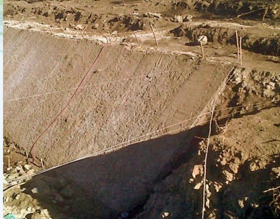
Construcción Biodigestor y estabilización de taludes
