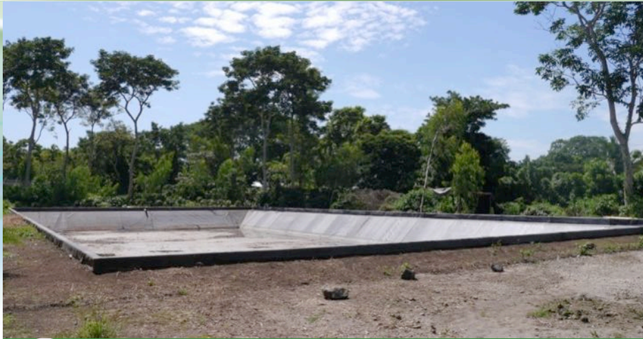
Laguna de descarga con revestimiento
