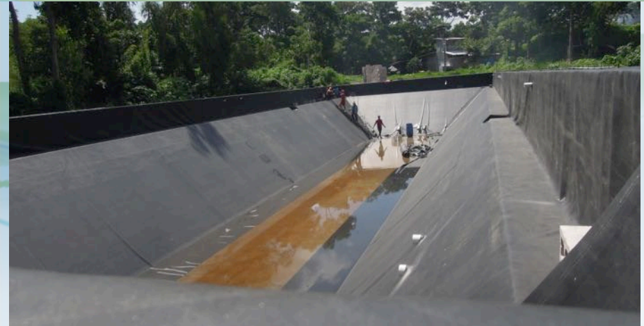
Laguna lista para iniciar pruebas de estanqueidad
