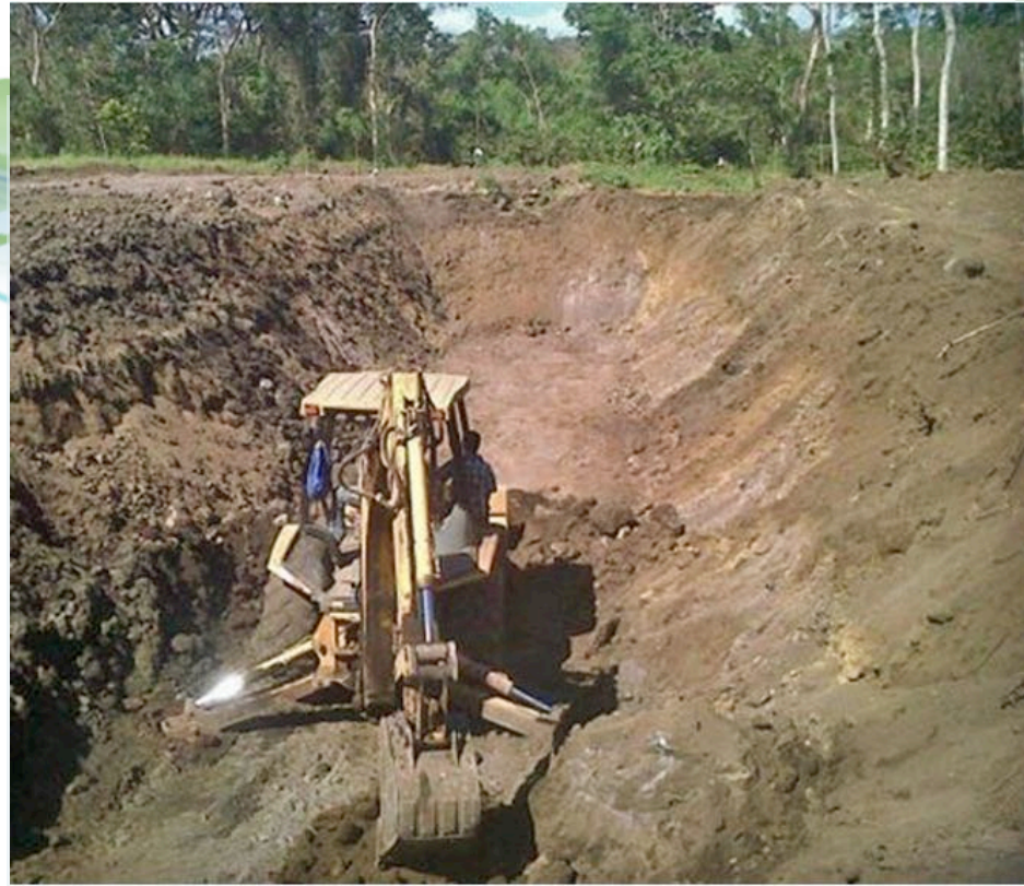
Inicio de la excavación
