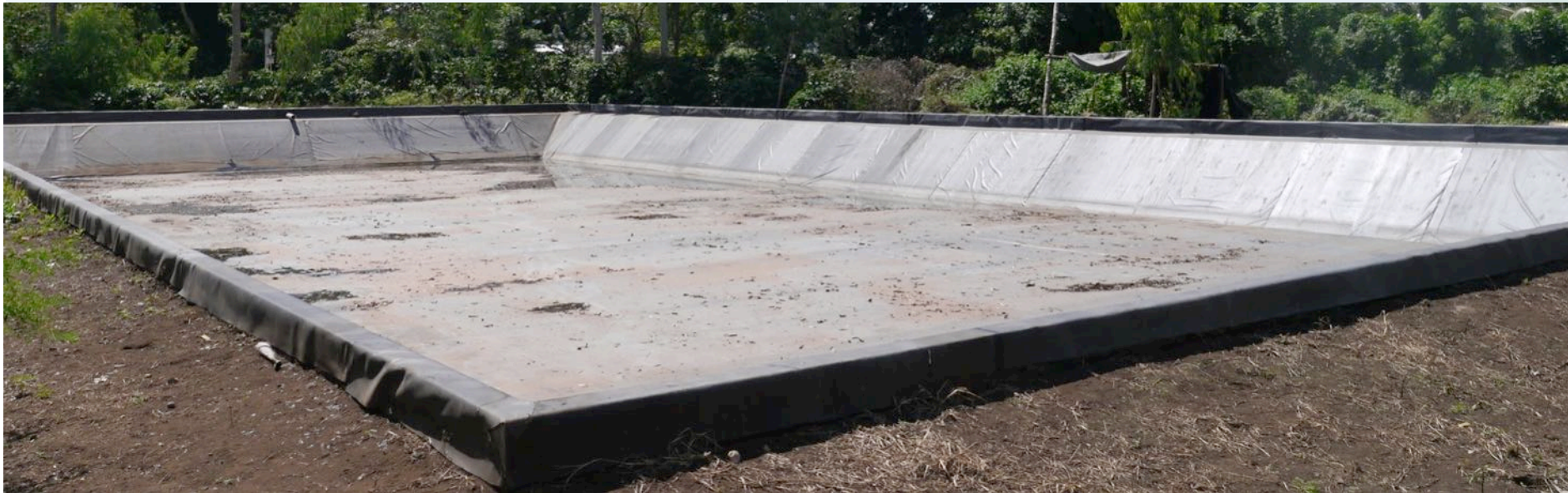
Laguna de descarga con revestimiento
