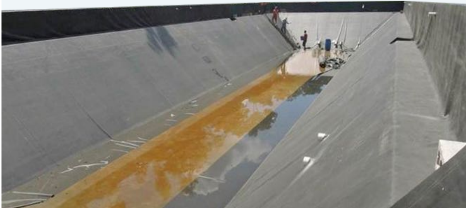
Construcción Biodigestor y estabilización de taludes
