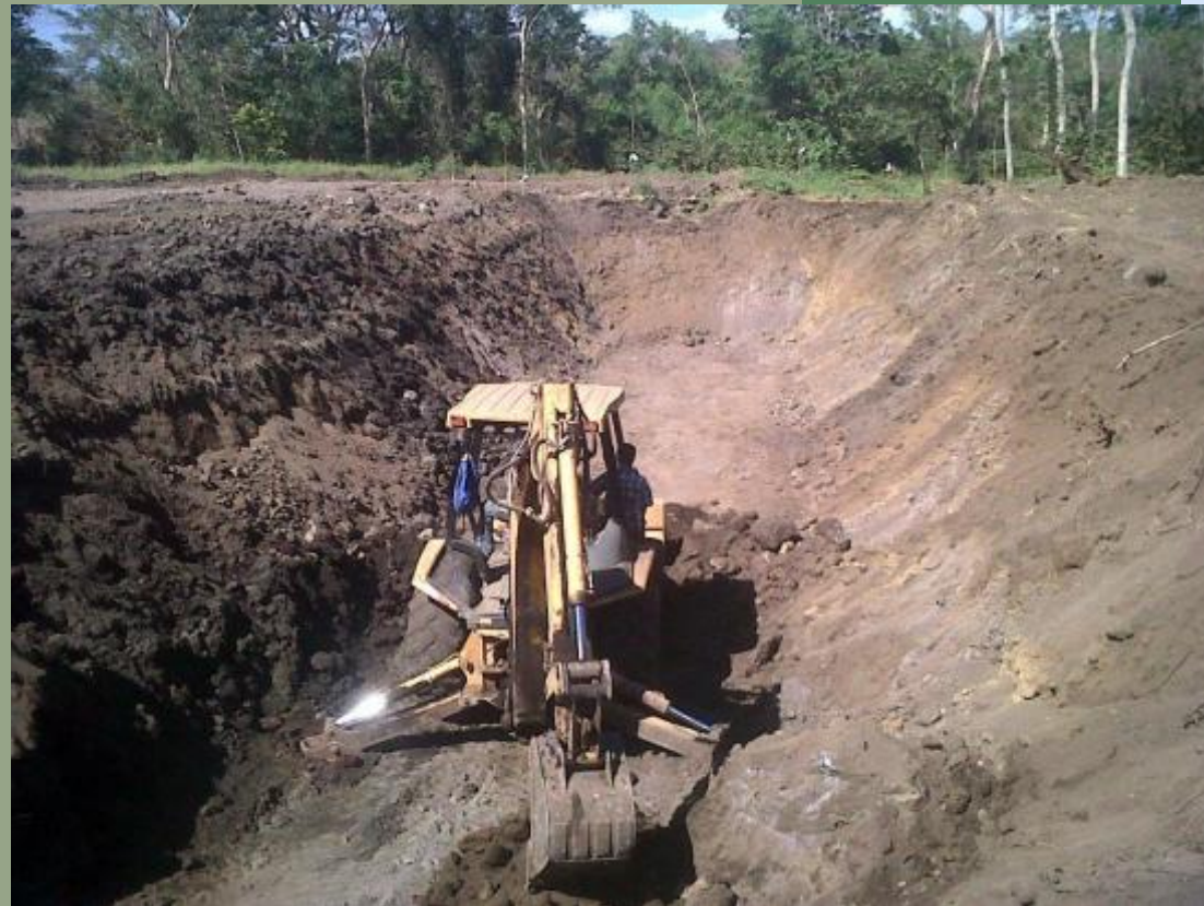
Construcción de la laguna de los biodigestores – volumen de biodigestor 1000 m3
