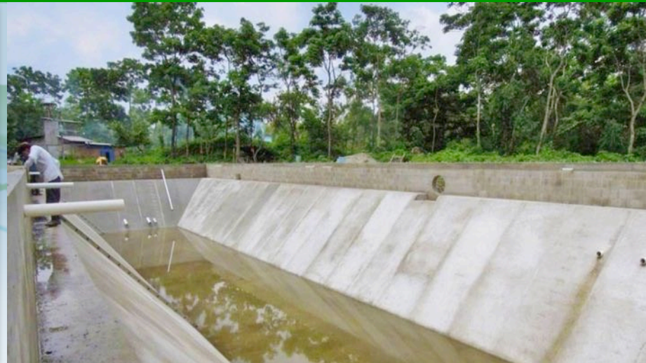
Taludes estabilizados
