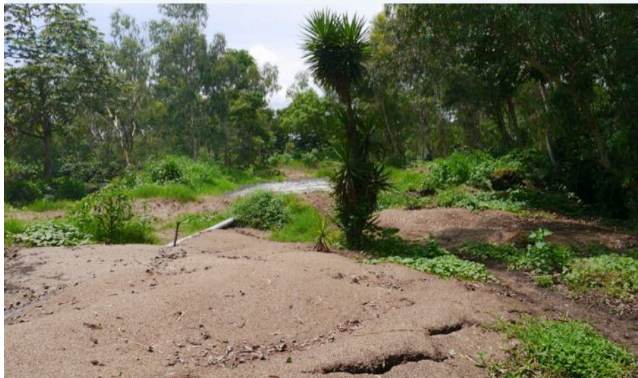
Planta de tratamiento – lodos activados
