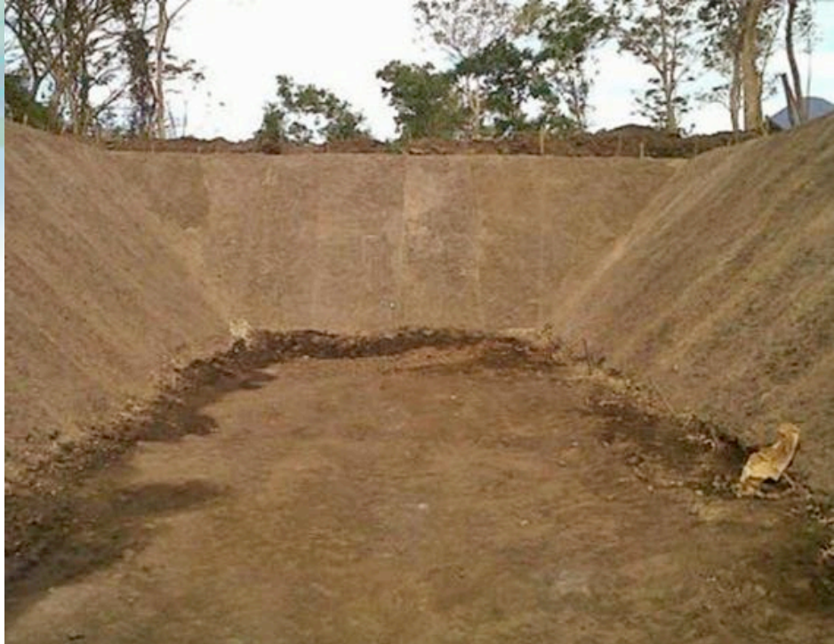
Construcción Biodigestor y estabilización de taludes
