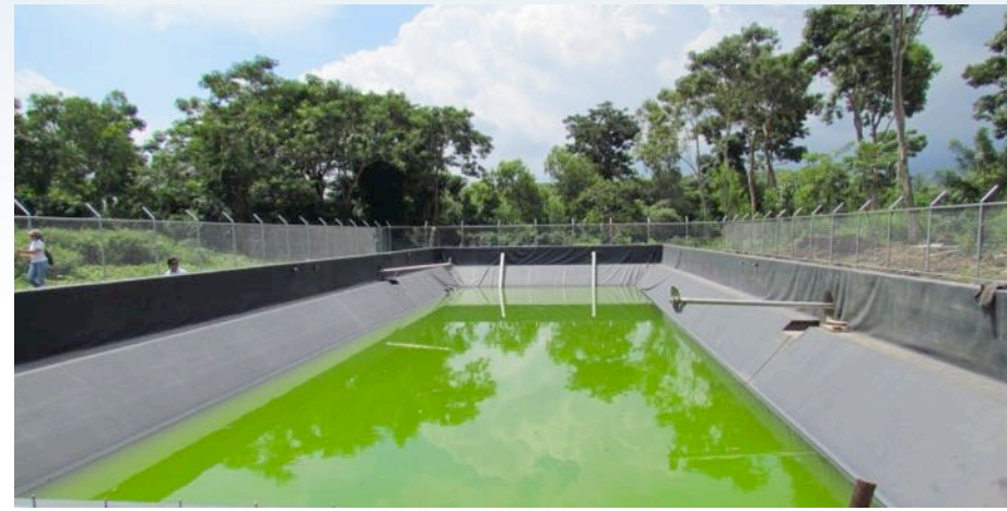
Taludes revestidos con membrana
