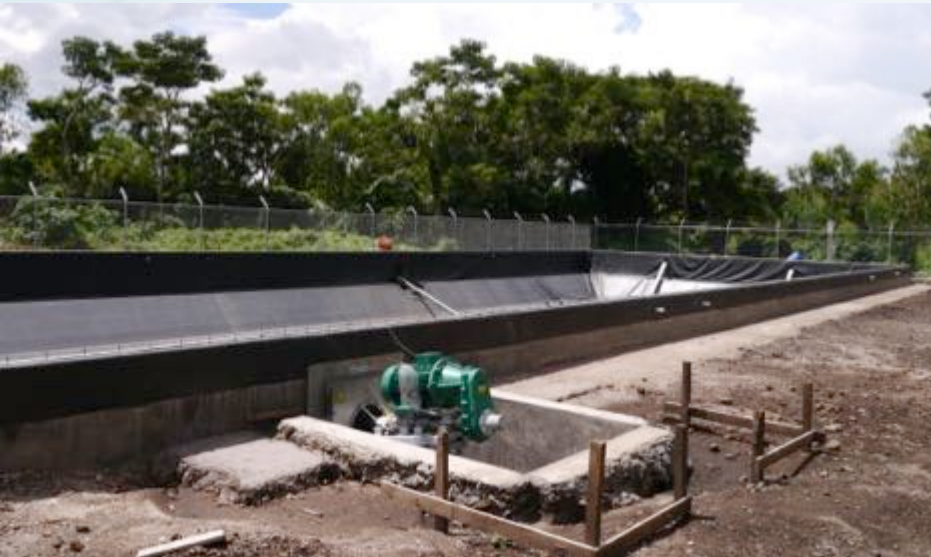
Instalación de agitadores
