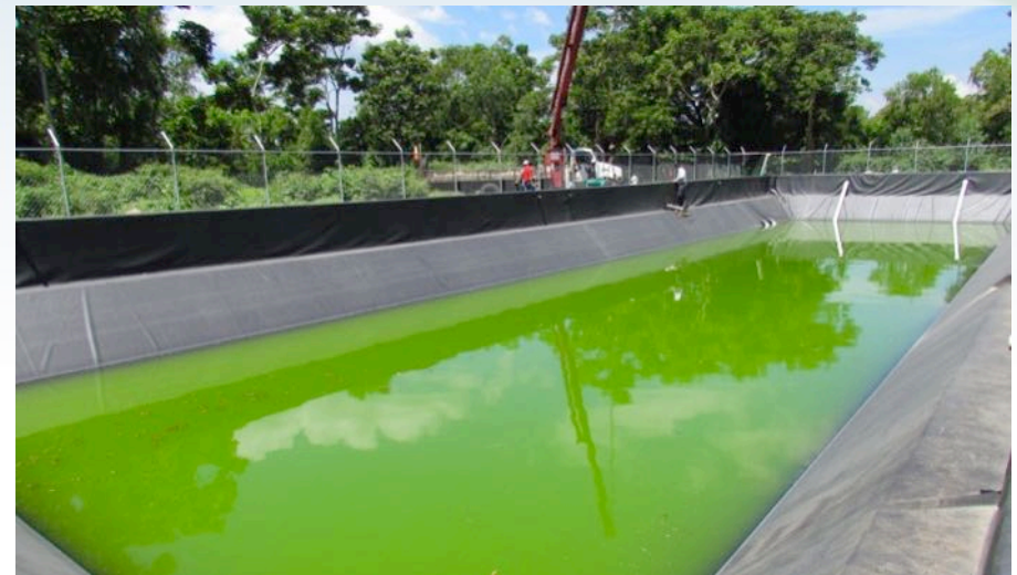
Laguna lista para iniciar pruebas de estanqueidad
