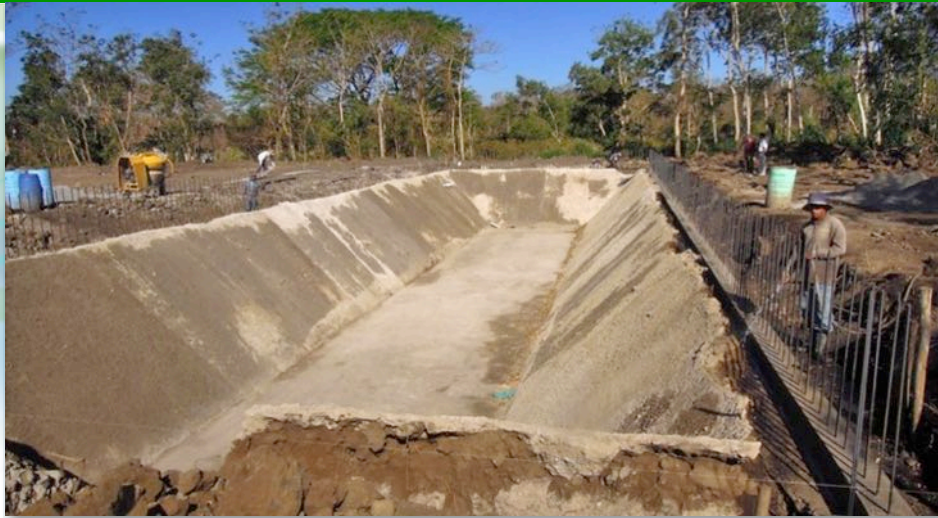
Construcción Biodigestor y estabilización de taludes
